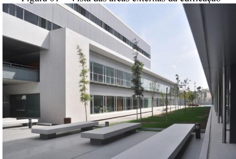
Figura 01 – Vista das áreas externas da edificação
